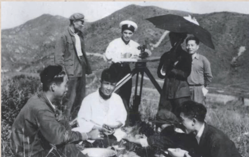
▲ 1959年，海测官兵在旅顺口进行海岸线平板仪测图（图片来自测绘历史资料）
