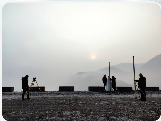
● 对小浪底大坝开展水准测量 张草原/摄
