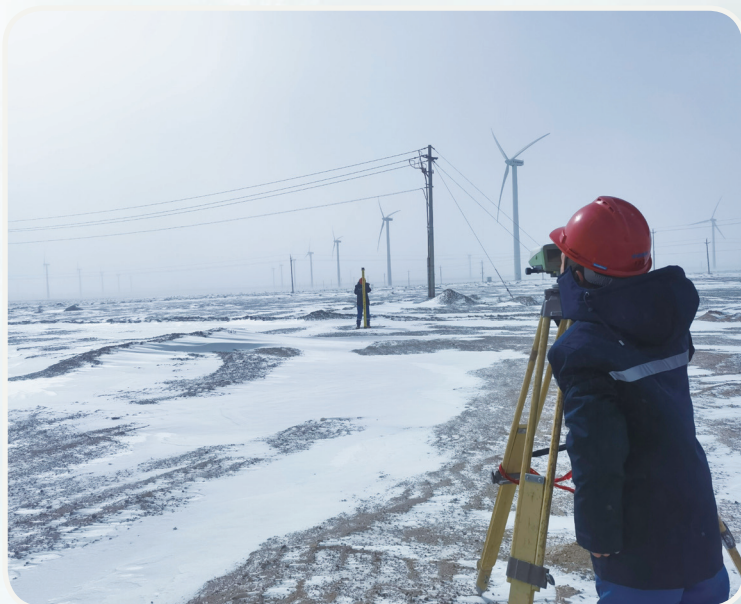
● 在甘肃酒泉开展风机沉降观测 李丙卓/摄
