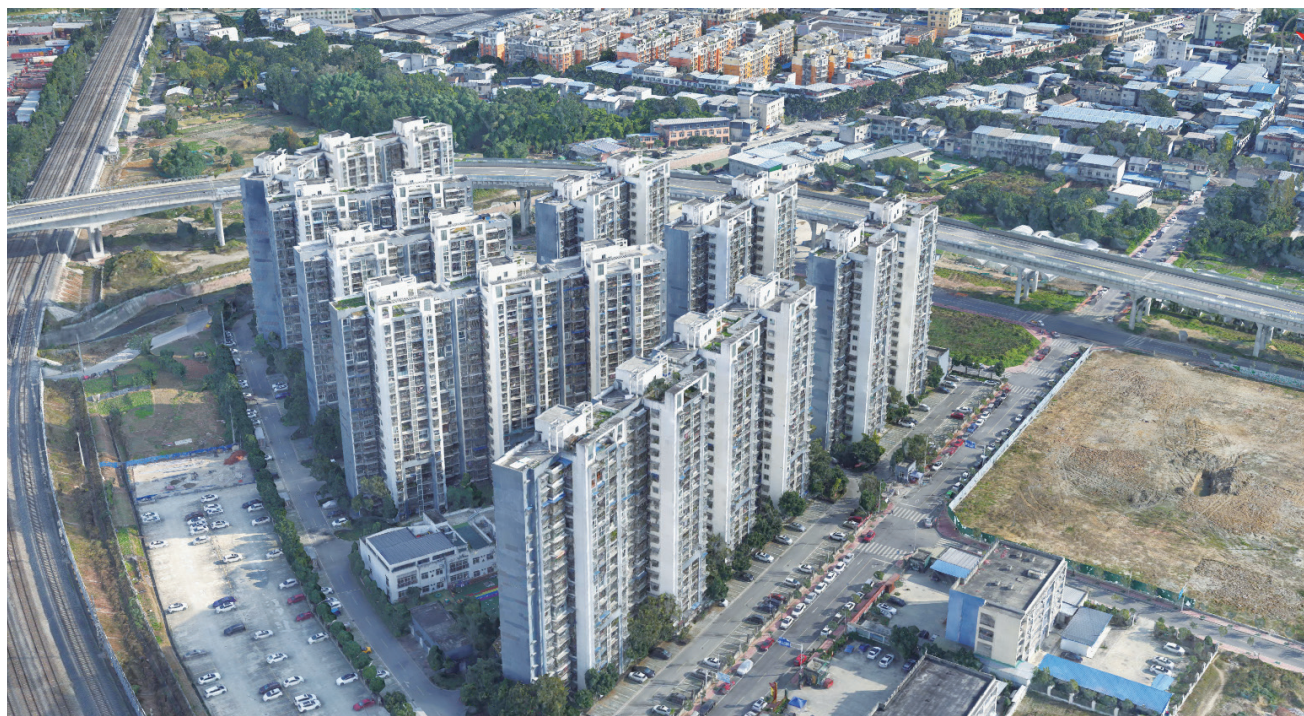
● 成都市青白江区实景三维场景
