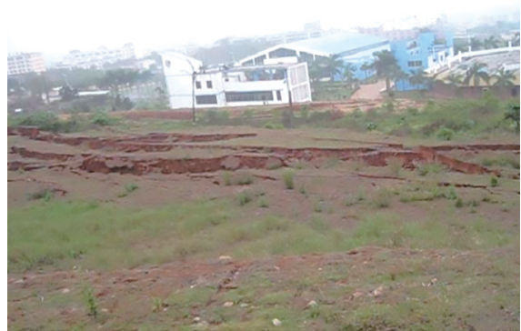
图4 滑坡体中部照片
