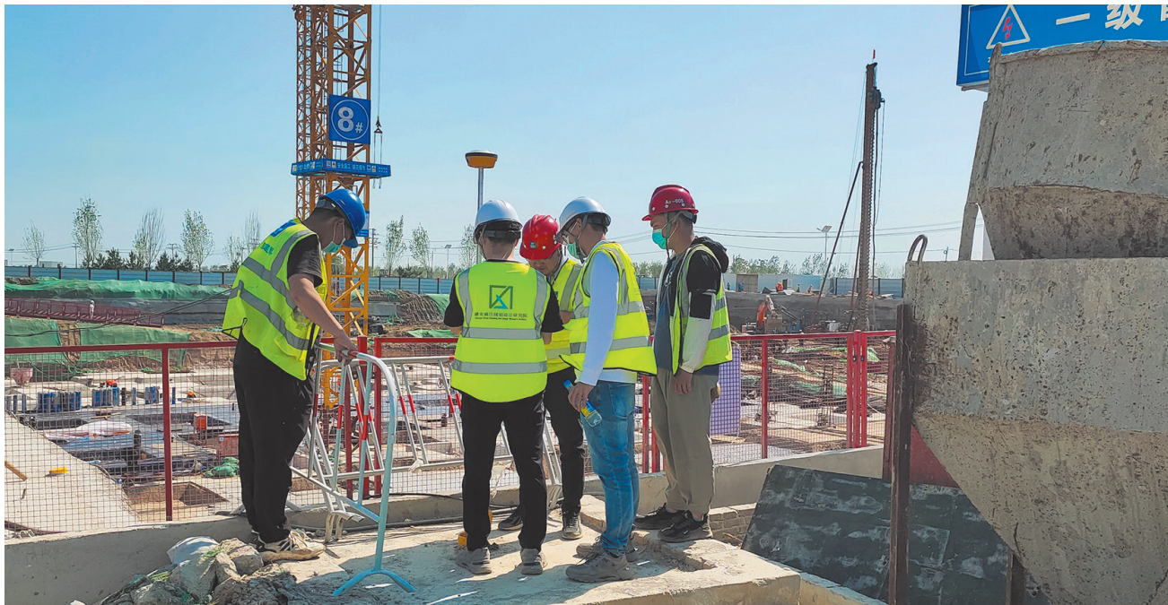
● 雄安新区“多测合一”测绘作业现场
