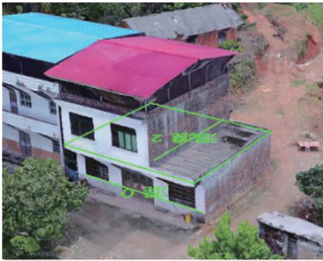
图5 面分割法房屋测量
