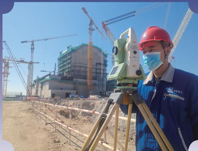
● 基坑水平位移观测 (郑州中核岩土工程有限公司 牛高博 / 摄)
