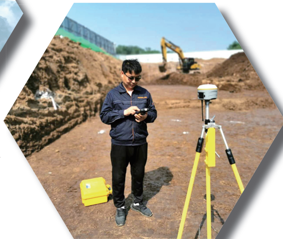
● 项目规划核验和施工放样 (河南省测绘工程院 焦贺军 / 摄)
