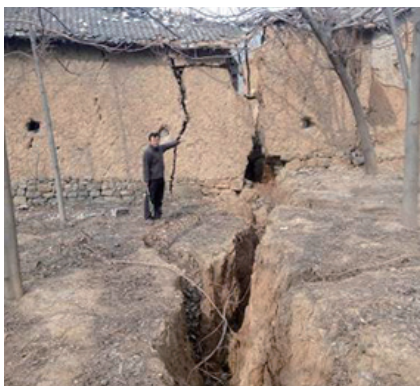
图4 济煤六矿北部地裂缝
