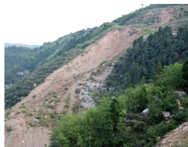
图8 滑坡现场照片
