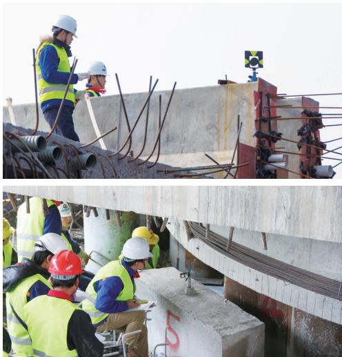
图2 转体过程中桥面位置监测和转盘处角度监测
